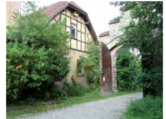
Schloss Tonndorf, südlich von Weimar gelegen, bietet viel Platz für die große Landkommune
